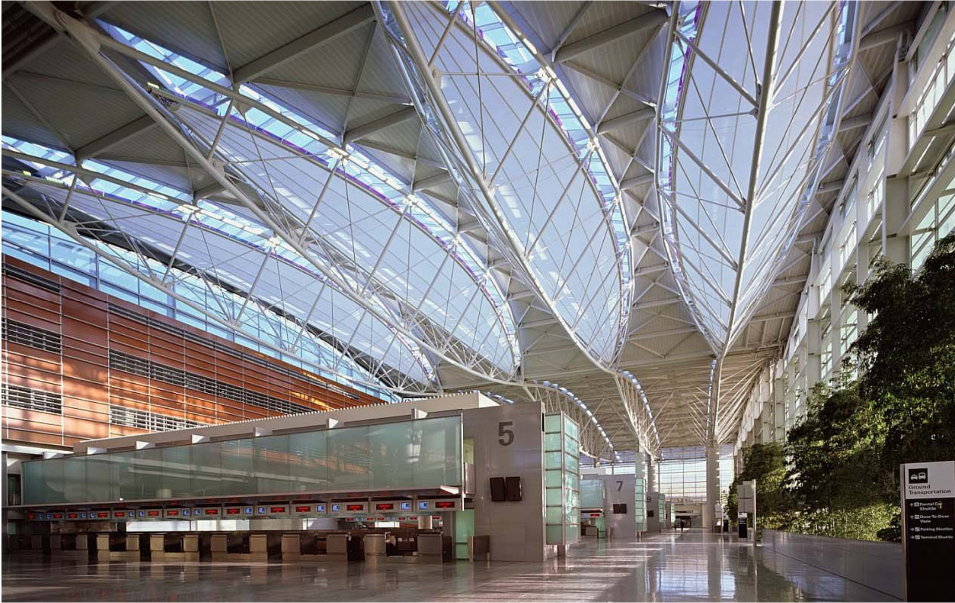
San Francisco International Airport SOM
