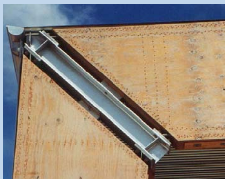
Giunti rinforzati con un profilo in acciaio
