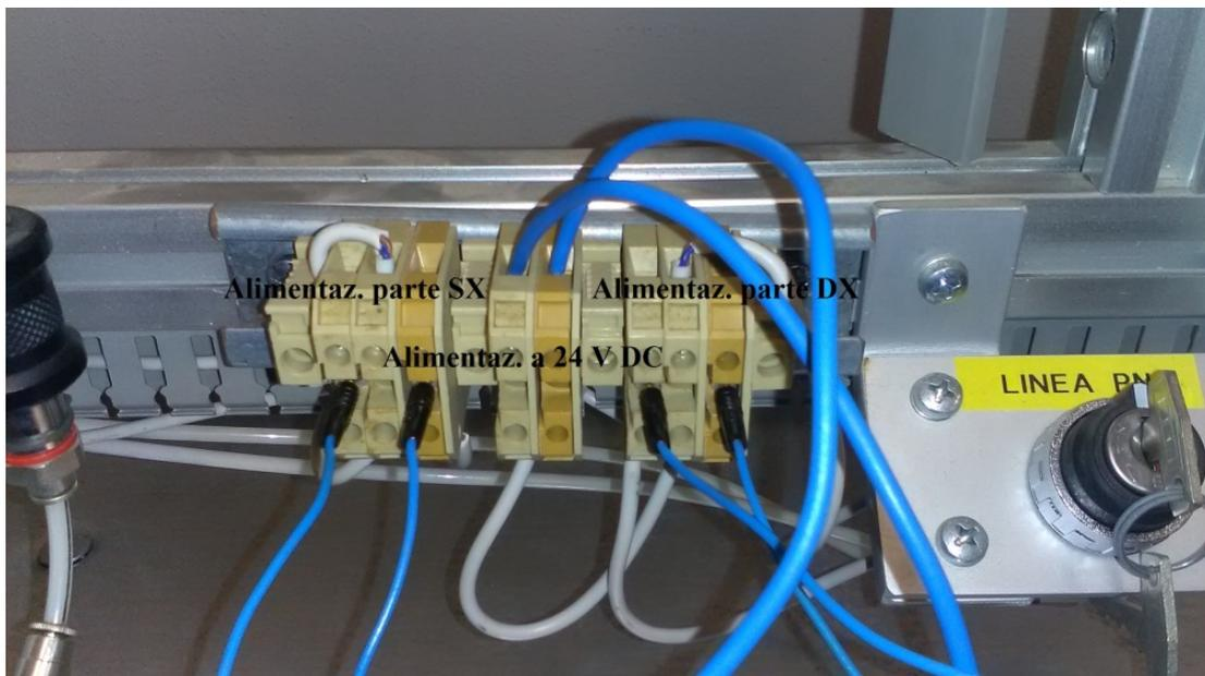
Figura 7: Alimentazione Pannello DX e SX a 24 V DC
